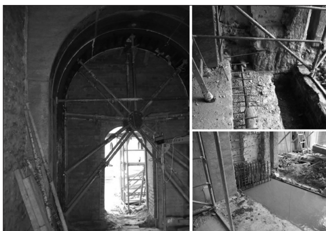
46. ábra: A vasbeton ívek építése, az ívek fémzsuzata
