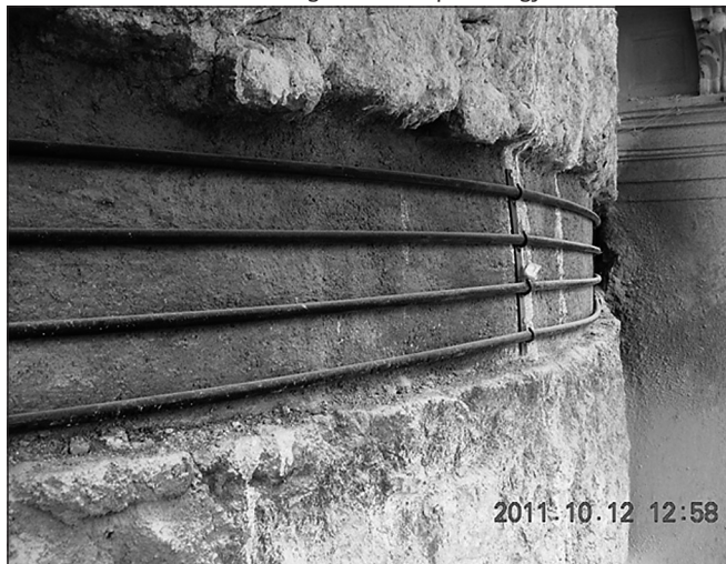
36. ábra: A lövellt betonkéreg és a feszítópázsma gyűrűk
