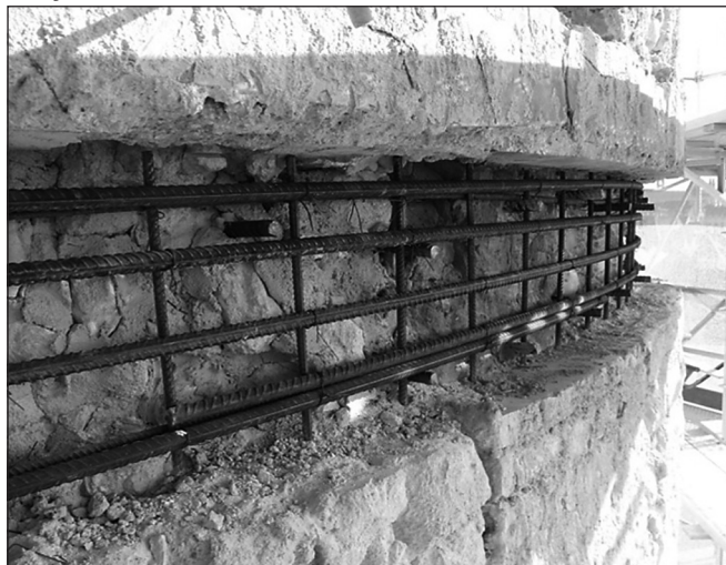
36. ábra: A lövellt betonkéreg és a feszítópázsma gyűrűk
