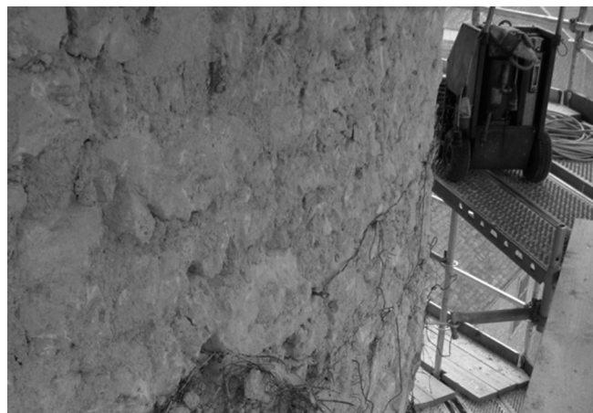
30. ábra: A kő jellemző struktúrája és a falazat jellemző képe
